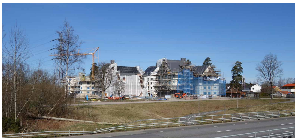
NY BEBYGGELSE I KV SNÖFLINGAN
