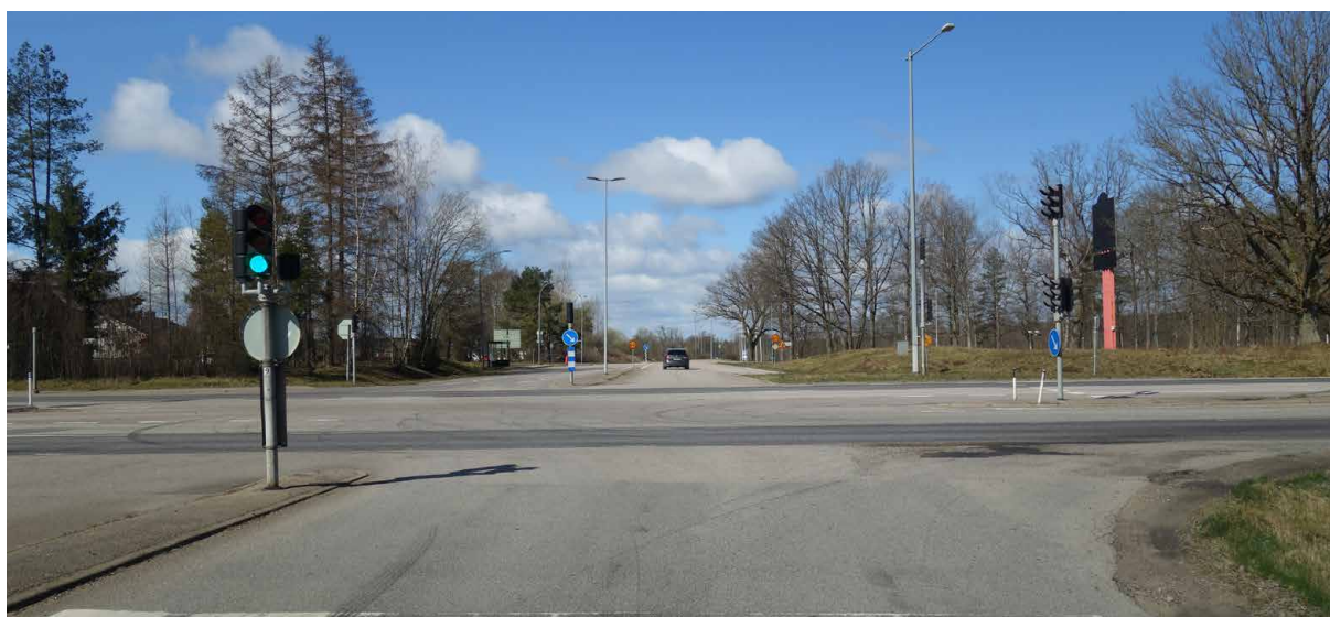
KORSNINGEN, FRÅN STORA RÅPPEVÅGEN MOT VÅSTER
