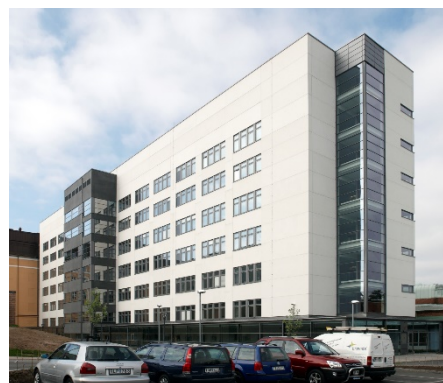
T-huset, Södra Älvsborgs sjukhus, Borås. Arkitekt: Sweco Bild Sweco. Bilden visar ett exempel där fasaden i sin helhet har en prägel av vertikalitet genom att fasadmaterialet fortsätter mellan; och delar upp; flera fönstergrupper. Men genom att låta flera fönster samverka nås inifrån karaktären av fönsterband med fönster från vägg till vägg.
